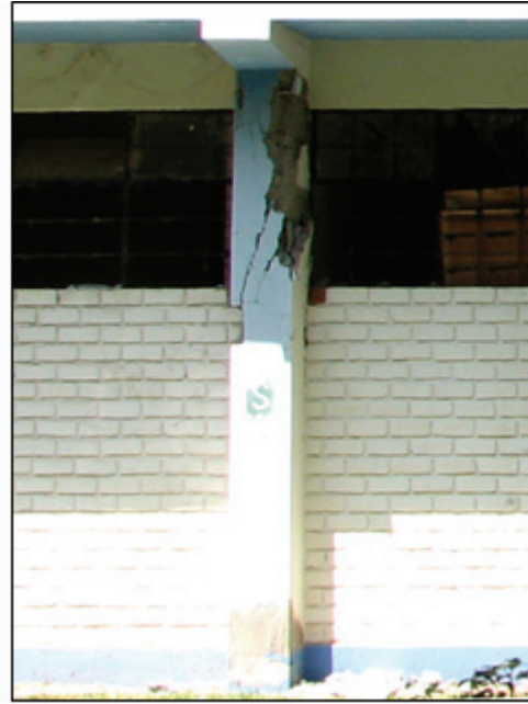
(d) Shear failure, CE19
